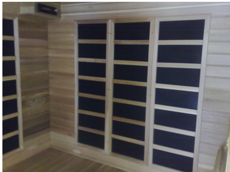
Figur 11 IR-kolfiberplatta bakom träribbor i en IR-bastu. Fotad av gruppen.
