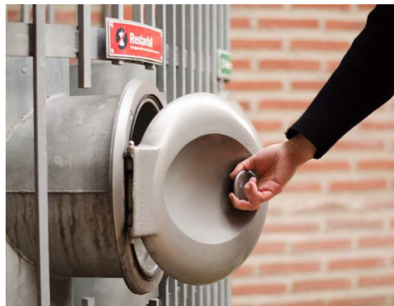
Figur 1.3. Sopsug i anslutning till en entré
