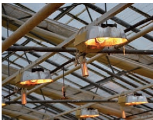
Figur 4.13. Olika typer av HPS-armaturer
