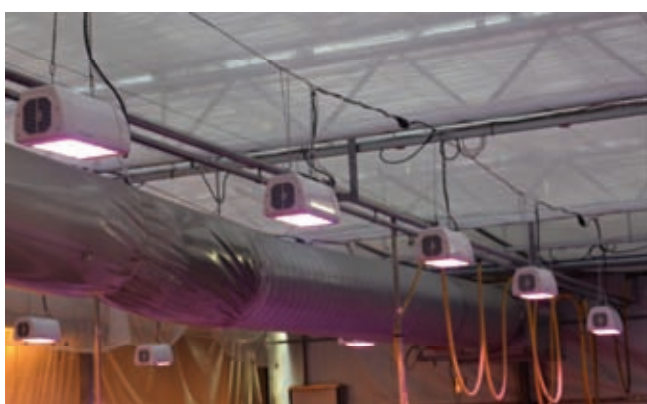
Figur 8.15. Dragning av ström- och nätverkskblar
