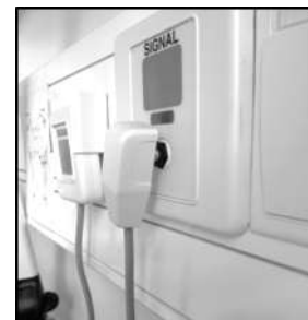
Figur 2.13 Kontakt som blivit utdragen ur uttag
