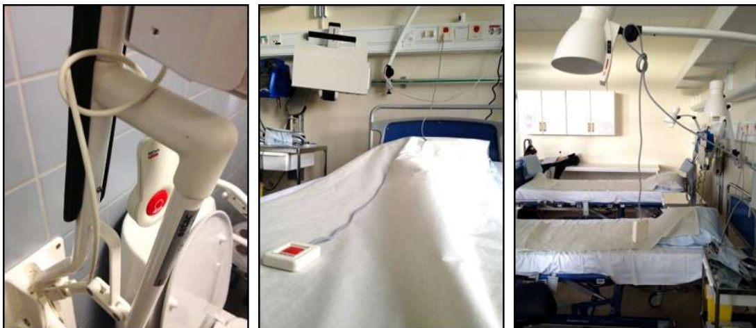
Figur 2.3 Positionering av larmdosa i vådrummet
